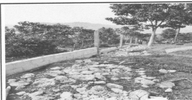
Foto 4: Se observan el uso de los materiales (piedras, hierros y arenas) para la construcción del muro perimetral
